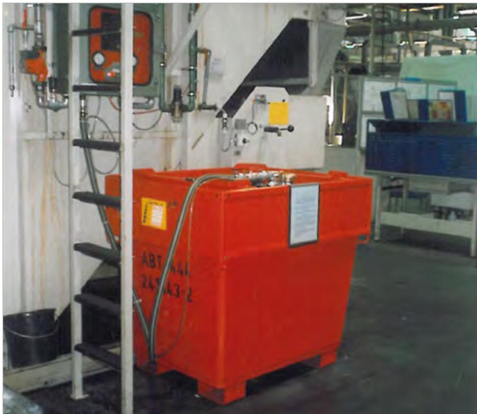
**Ver- und Entsorgung von entzündbaren Flüssigkeiten mit einem Flammpunkt > 55°C.**
